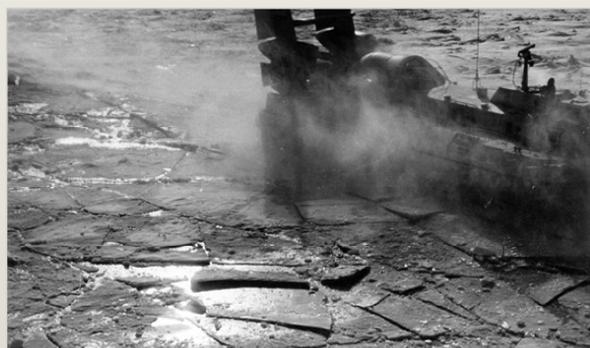
Разрушение льда ДКВП «Скат» (вес судна 20,5 т., толщина льда 50-60 см.)
